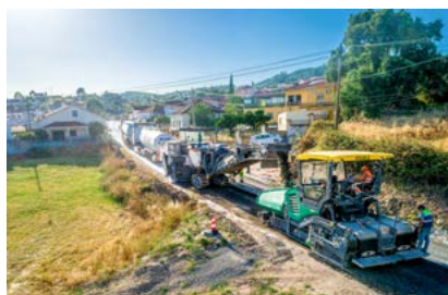
Ausfräsen, Aufbereiten, Einbauen und Verdichten – ökologische Straßensanierung mit Technik der Wirtgen Group.
