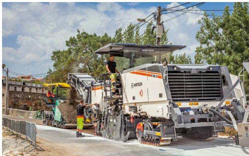
In Monsanto recycelte der leistungsstarke Wirtgen W380 CR mit Heckverladung die Fahrbahn 16 cm tief unter Zugabe von Schaumbitumen und vorgestreutem Kalk. Bildquelle: Wirtgen Group
