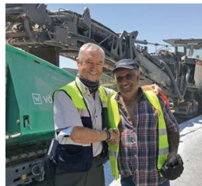
Vorarbeiter Pedro Silva vom Bauunternehmen Pragosa und Wirtgen Recycling-Experte Mike Marshall (links) waren sich einig: In-place Kaltrecycling mit dem W 380 CR ist extrem schnell und wirtschaftlich. Bildquelle: Wirtgen Group
