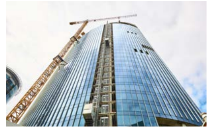
Hochhaus-Baustelle in Brüssel
